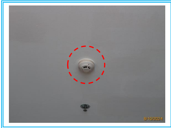
รูปที่ 3.1-24 Smoke Detector
