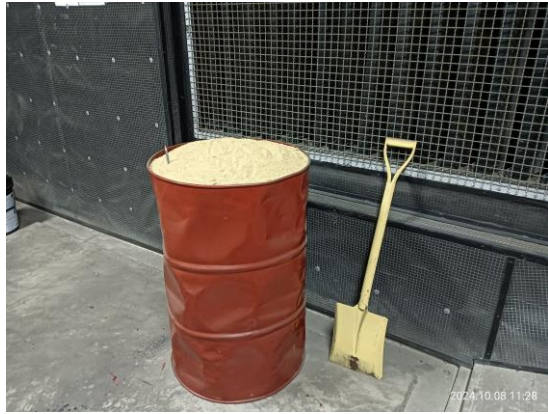
รูปที่ 3.1-46 ทราบดีดน้ำมันหกรั่วไหล
