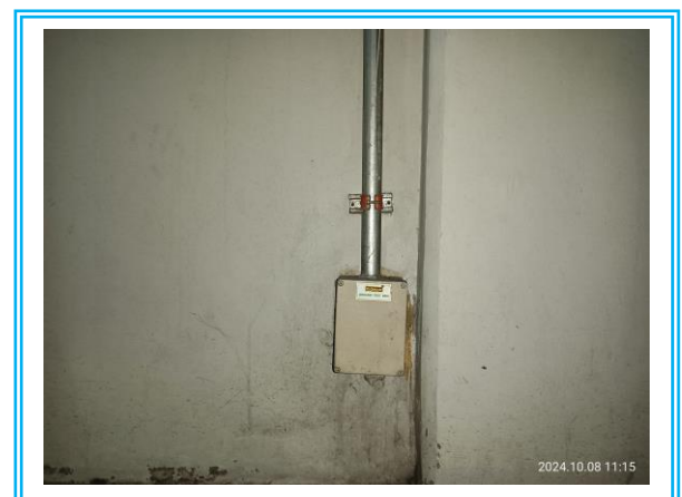
รูปที่ 3.1-44 การติดตั้งสวิตช์เปิด/ปิดเครื่องปรับอากาศ แยกออกจากกันในแต่ละพื้นที่ของอาคาร
