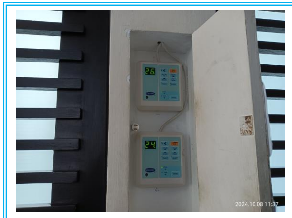
รูปที่ 3.1-44 การติดตั้งสวิตช์เปิด/ปิดเครื่องปรับอากาศ แยกออกจากกันในแต่ละพื้นที่ของอาคาร
